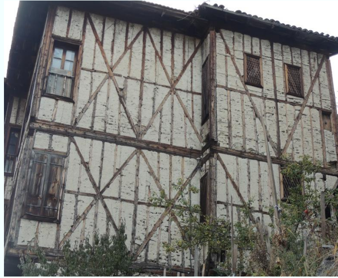
Şekil 4. 23 X ve V çaprazlarının kullanıldığı çerçeve örnekleri
