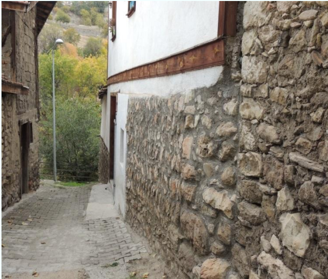
a-) duvar altı temel
