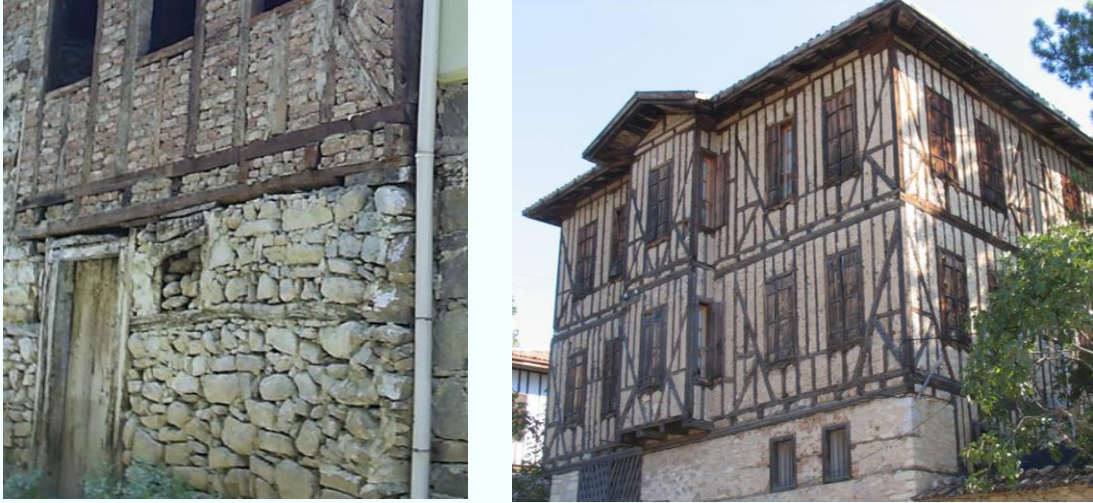
Şekil 3. 38 Tek yönde çift tabanlı yapı örnekleri [39][45]
