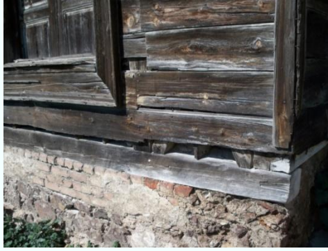
Şekil 3. 2 Kâgir yığma duvar üzerindeki ahşap taban kuşakları [31]
