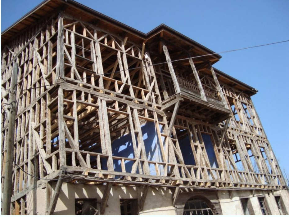
Şekil 3. 10 Ahşap çatkının oluşturulması, Osmaneli
