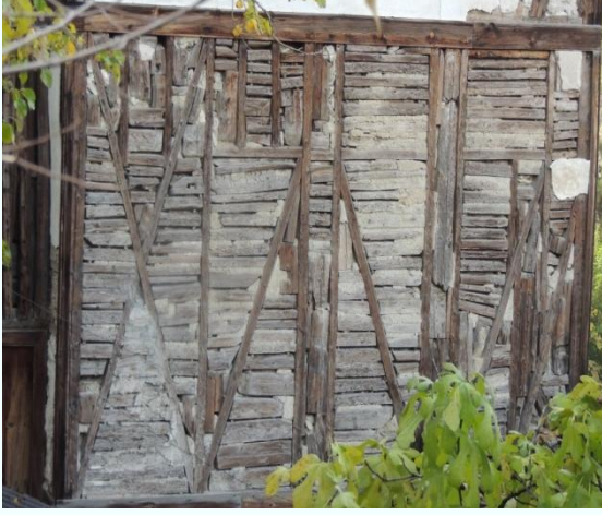
Şekil 4. 28 Örneklemeye bölgesinde ahşap dolgulu çerçeve
