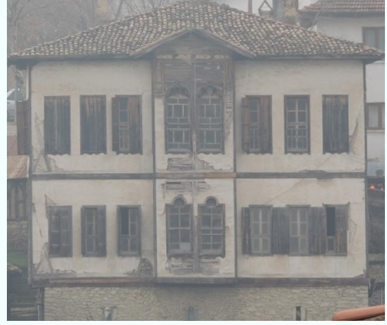
Şekil 4. 29 Çıkmalarda ahşap dolgu kullanımı
