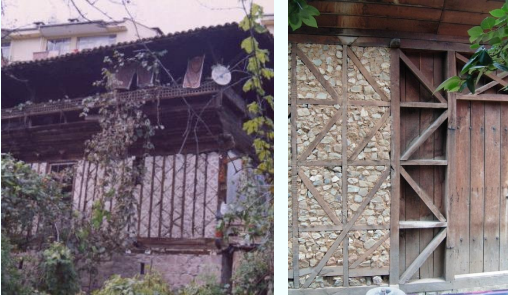
Şekil 3. 23 Muska dolma duvar örnekleri [31]
