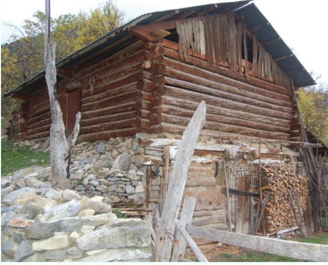
Kütüklerle oluşturulmuş ahşap yığma duvarlar [33]
