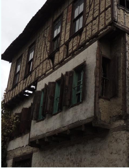
Şekil 4. 36 Konsol çıkma örneği
