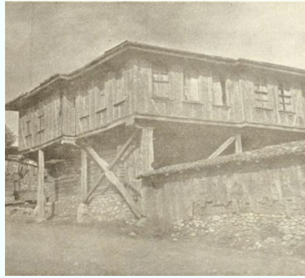
Şekil 3. 3 Bağımsız taş temeller [32]
