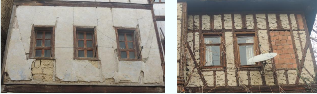
Şekil 4. 22 Payanda ve destekli payanda çaprazı örnekleri
