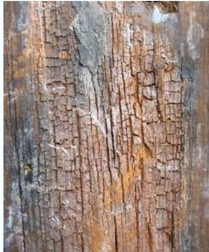
Şekil 2. 10 Ahşabın çürümesi [16]
