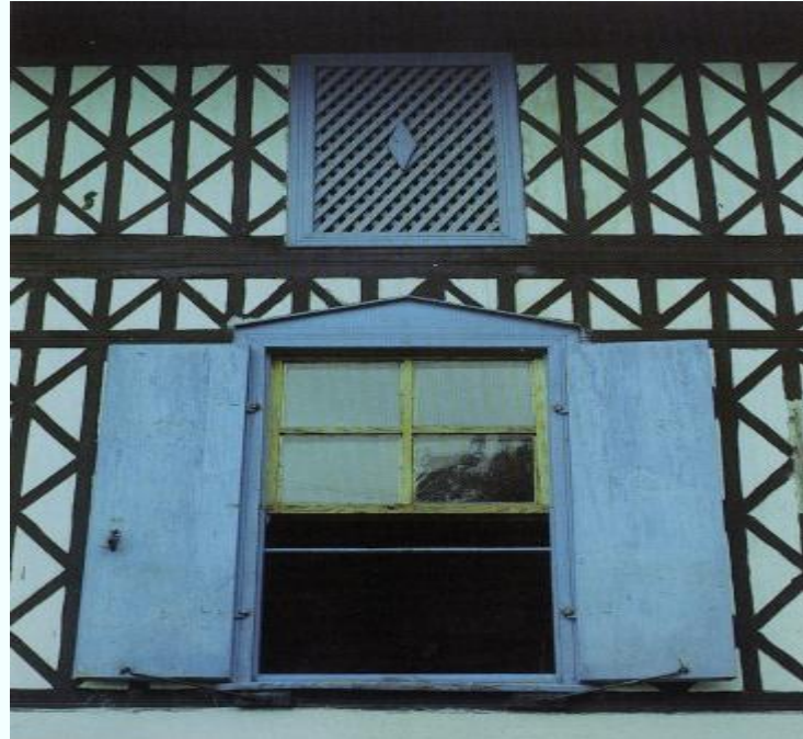
Şekil 3. 25 Muska dolma duvarda dolgu malzemesinin sıvanması [41]
