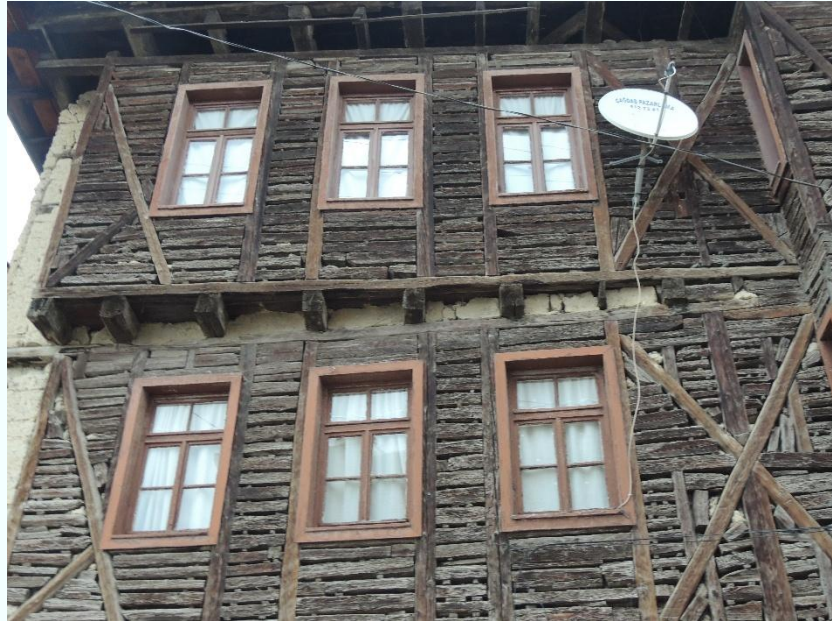
Şekil 3. 17 Dizeme tekniği ile yapılmış duvar örneği, Safranbolu, Bulak Köyü
