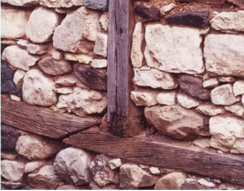
Şekil 3. 54 Taban kuşağında eğri ek yapılması [1]
