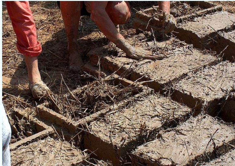
Şekil 2. 20 Kerpiç üretilmesi [25]
