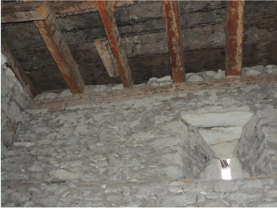
Şekil 3. 33 Ahşap döşeme kirişlerinin yerleşimi
