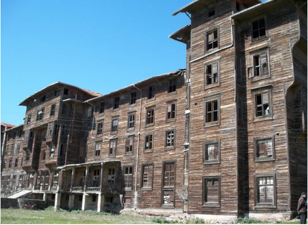
Şekil 3. 12 Yalı baskısı tekniğiyle kaplanmış ahşap yapı örneği [35]
