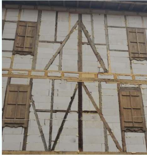
Şekil 4. 25 Çapraz elemanlarda açığa uyma
