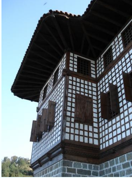
Şekil 3. 31 Dolgu malzemesinde badana [43]
