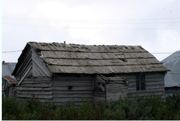
Şekil 3. 48 Hartama kullanılmış çatı örneği [58]
