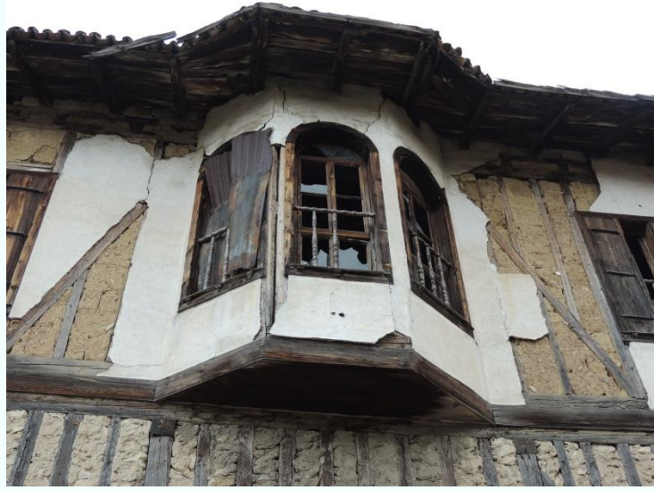
Şekil 3. 44 Çıkmada manzara ve rüzgâr yönü için pencere açılması
