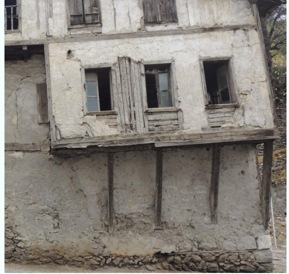
Şekil 4. 37 Destekli çıkma örneği
