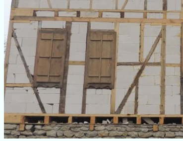
Şekil 4. 30 Fabrika ürünü dolgu malzemeleri (soldan sağa briket, gaz beton, tuğla)
