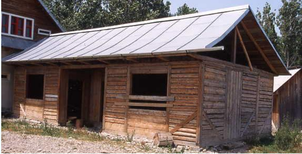
Şekil 3. 8 Bok ahşap dolma duvar örneği [35]
