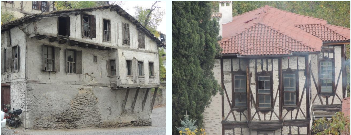
Şekil 3. 43 Ahşap yapılarda çıkmalar
