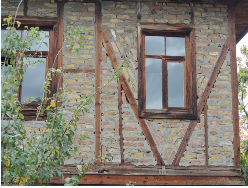
Şekil 2. 22 Tuğla dolgu malzemesi örneği, Safranbolu
