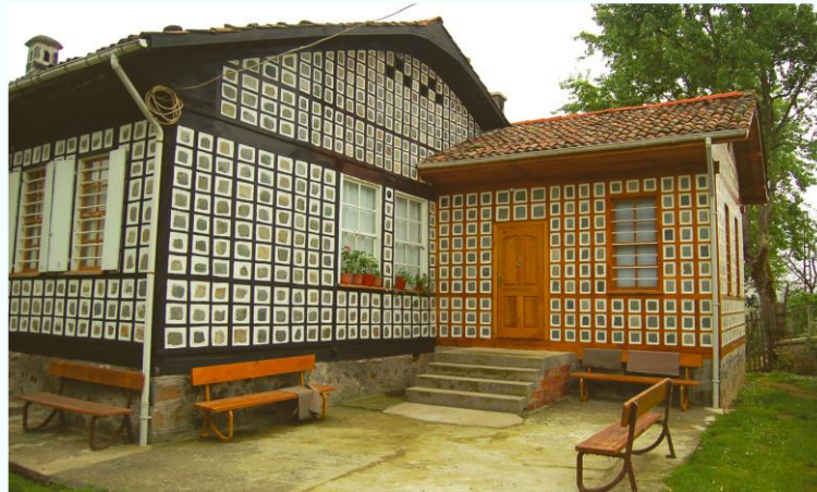
Şekil 3. 28 Göz dolma duvarlı yapı örneği [33]
