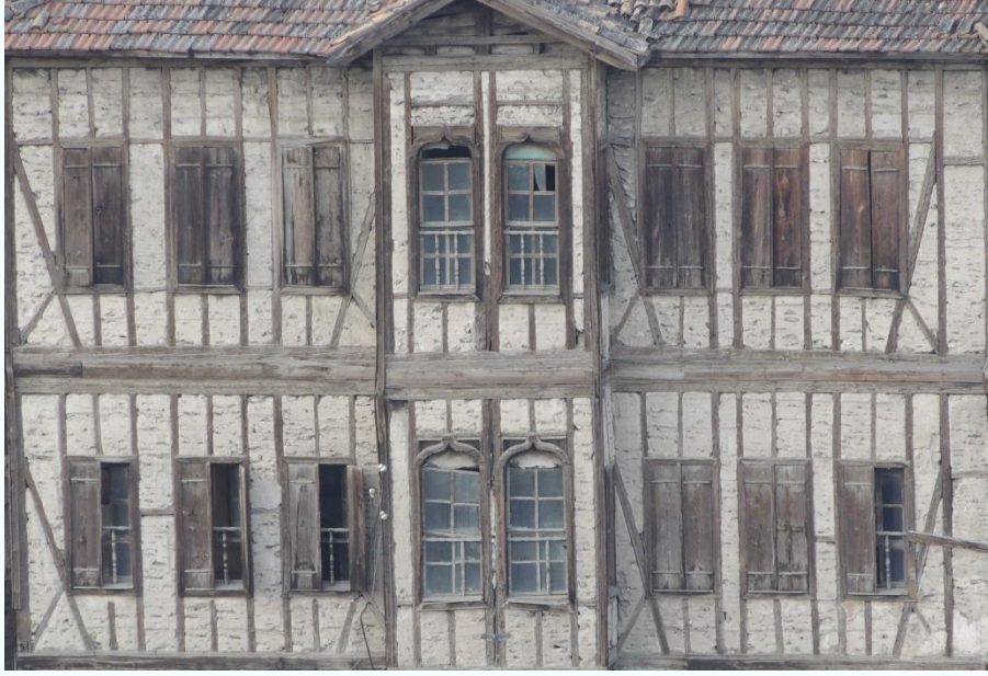
Şekil 3. 19 Hımış duvar örneği, Safranbolu
