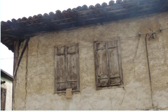
Şekil 4. 15 Kireç harcı ile sıvanmış duvar
