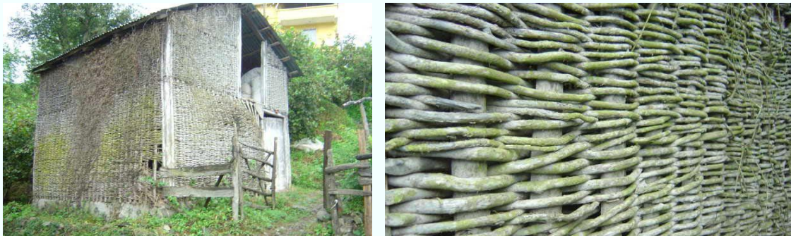
Şekil 3. 15 İnce dallarla oluşturulmuş çöten duvar örneği [39]
