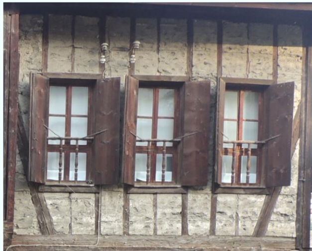
Şekil 4. 19 Ahşap çatıklı çerçevede ana ve ara dikmeler
