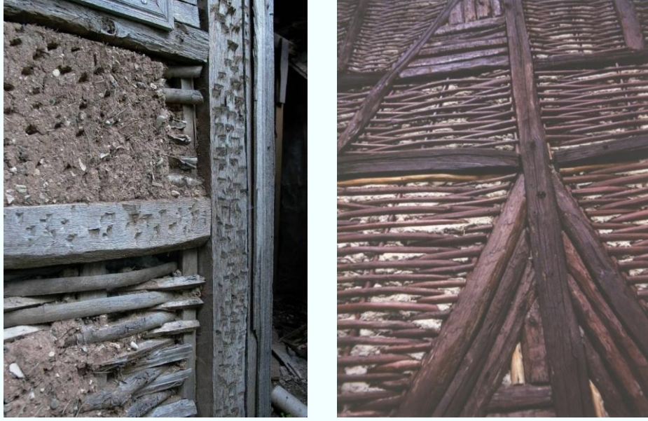
Şekil 3. 16 Çöten duvarlarda dalların arasının sıvanması [39]
