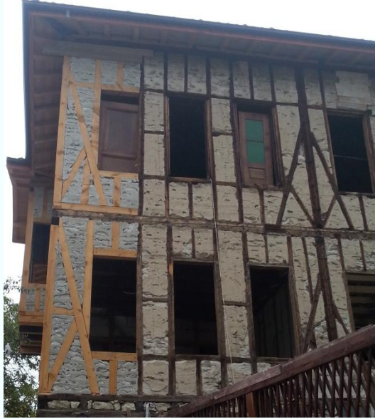
Şekil 4. 33 Yatay kayıt adedinin kat yüksekliğine göre değişmesi
