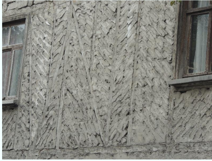
Şekil 3. 21 Balıksırtı tuğla dolgulu duvar örneđi, Safranbolu
