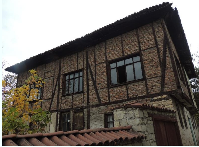
Şekil 3. 20 Tuğla dolgulu hımış duvar örneđi, Safranbolu
