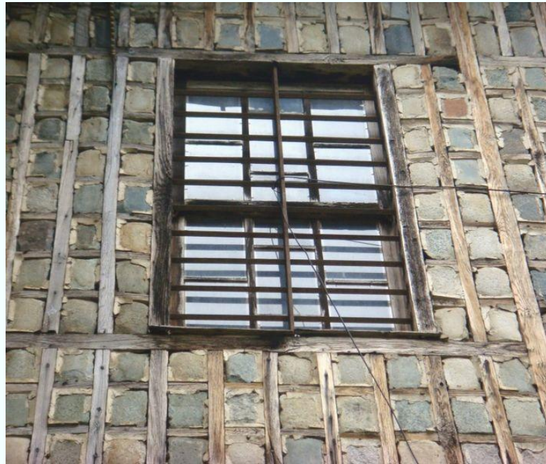
Şekil 3. 30 Blok taş dolgulu göz dolması duvar örneği [43]
