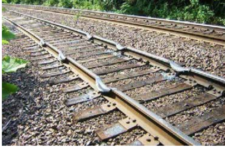
Şekil 4.23. Lokomotifin olduğu yerde patinajı sonucu oyulma
