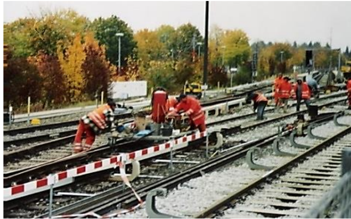
Şekil 4.42. Almanya Münih Neuperlach İstasyonunda ray kaynağı çalışmaları, ön ısıtma (Foto E. Sevil)
