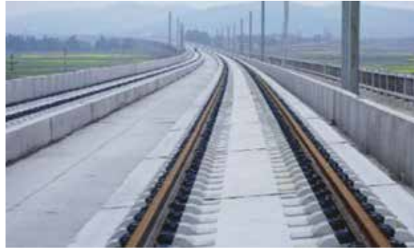
Şekil 6.4. Züblin tipi üstyapı (genel görünüşü)
