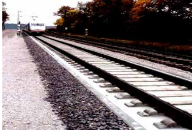
Şekil 6.8. Heitkamp üstyapı sistemi
