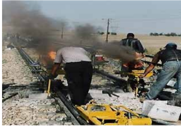
Şekil 4.43. Konya – Ulukışla arasında termit kaynağı çalışmaları (Foto E. Sevil)
