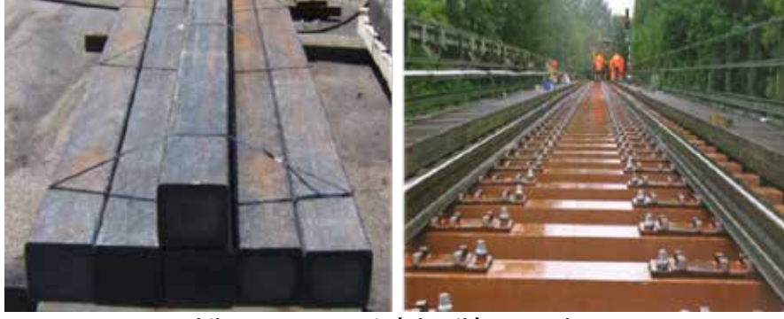
Şekil 3.21. Kompozit (plastik) traversler
