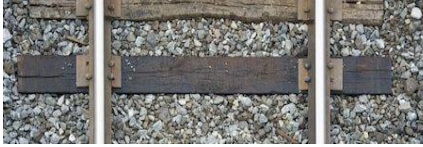
Şekil 3.4. Ahşap travers
