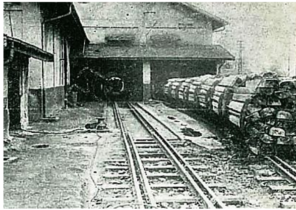
Şekil 3.9. Derince ahşap travers enjekte fabrikası
