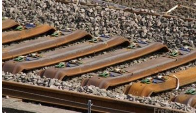
Şekil 3.11. Demir travers
