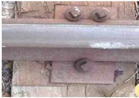
Şekil 5.12. N tipi bağlantı
