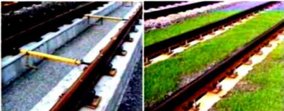
Şekil 6.22. Çimle kaplı üstyapı sistemi
