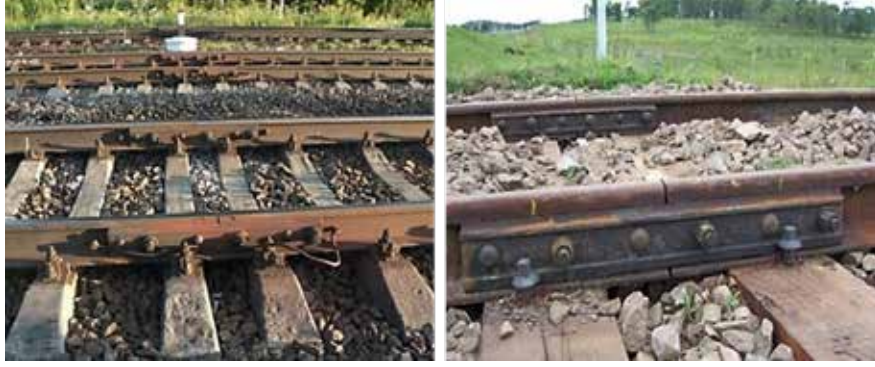
Şekil 4.33. Rayların birleşme yerleri (Conta)
