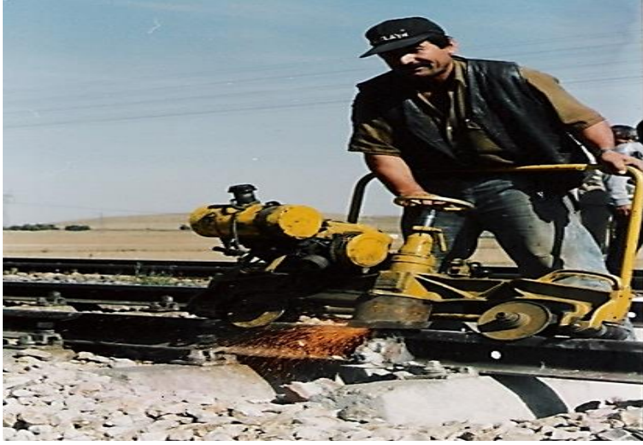
Şekil 4.47. Konya - Ulukışla arası kaynak çalışmaları ray taşlama (Foto E. Sevil)
