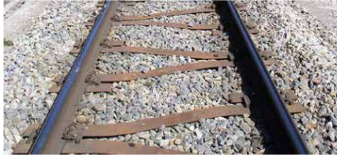
Şekil 3.13. Y tipi demir travers
