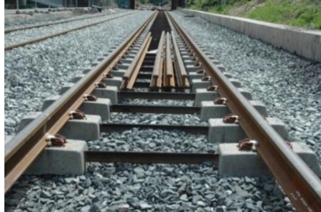
Şekil 3.18. İki bloklu, balastlı yol beton traversleri
