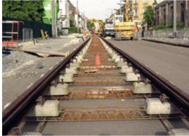
Şekil 3.19. Tramvay hattına uygulanan, iki bloklu, balastsız hat beton traversi
