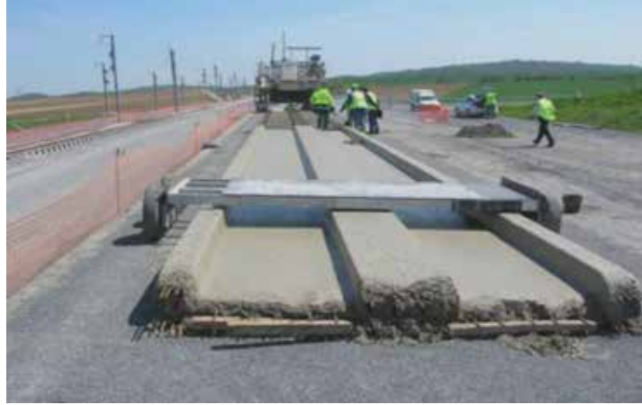
Şekil 6.10. Stedef sistemi beton tabakanın hazırlanışı
