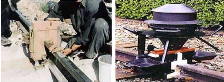
Şekil 4.45. Prefabrik kalıp ve pota
