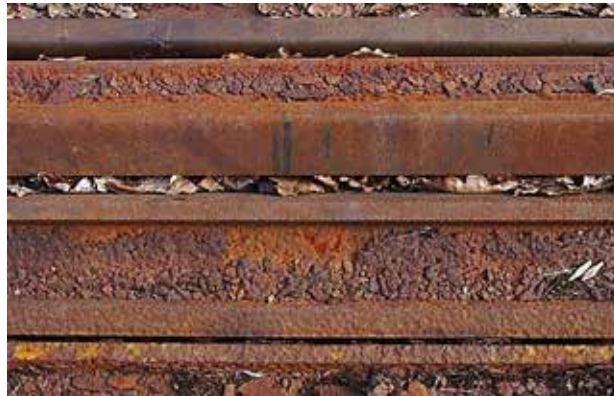
Şekil 4.28. Korozyon
