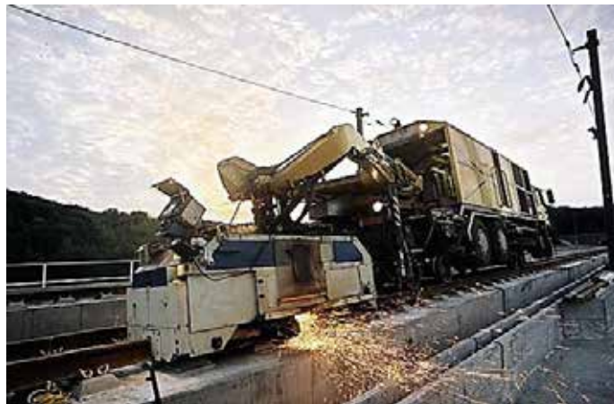
Şekil 4.44. Alın kaynağı çalışmaları
