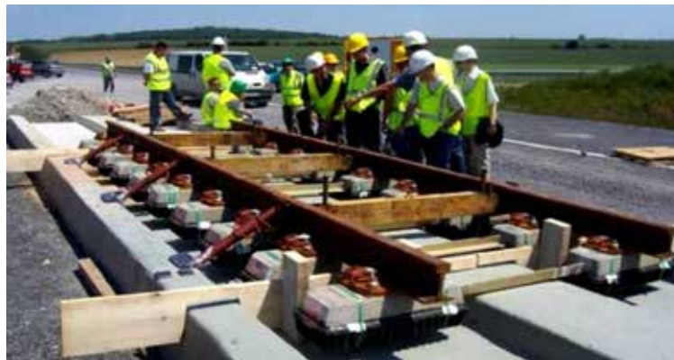
Şekil 6.11. Stedef üstyapı sisteminin montajı
