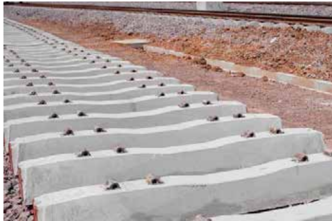
Şekil 3.14. Betonarme traversler
