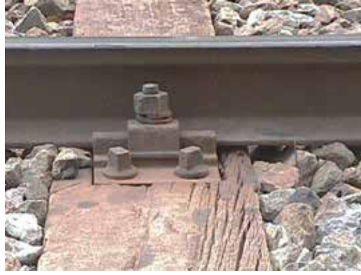
Şekil 5.10. Ahşap traversste K tipi bağlantı
