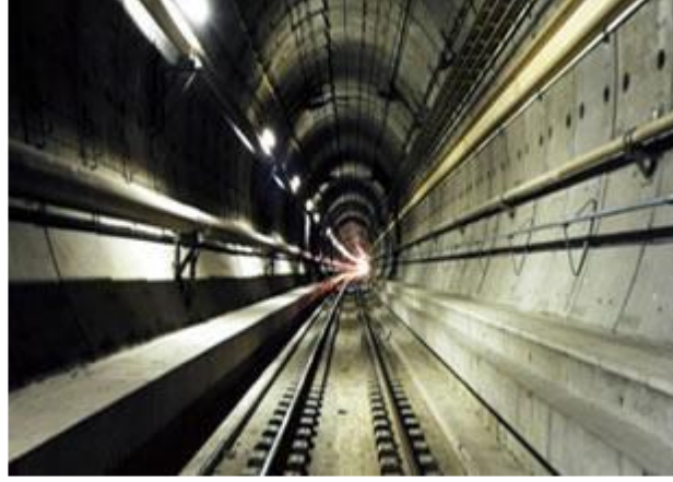
Şekil 6.12. Manş tüneline Sonneville üstyapı sistemi
