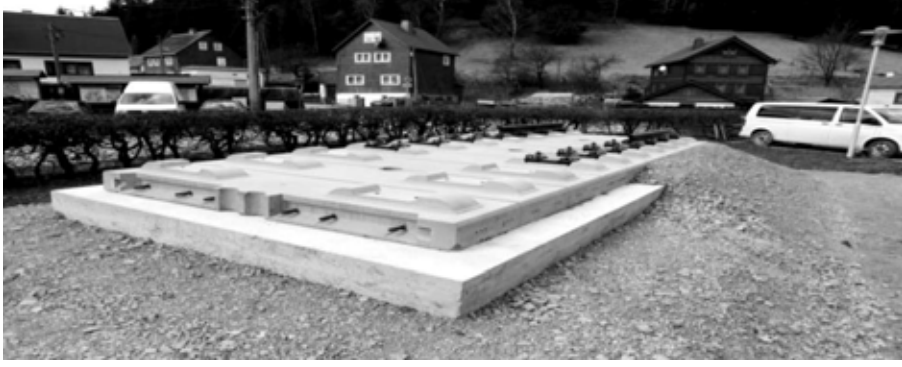
Şekil 6.20. Bögl tipi üstyapı bitmiş durumda
