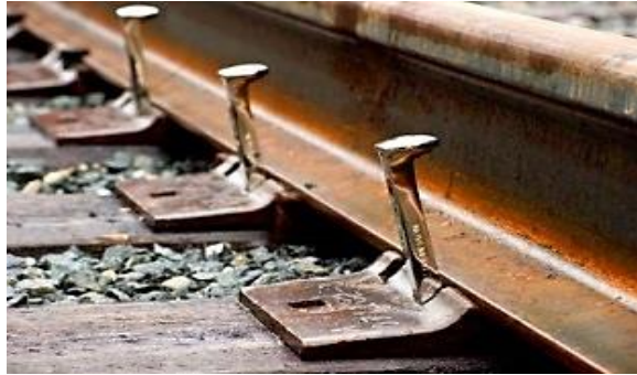
Şekil 5.6. Krampon çivisi ile Ray – Traverse bağlantısının sağlanması
