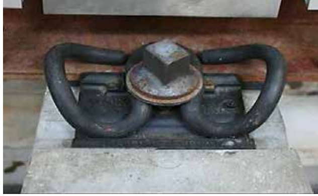
Şekil 5.17. HM tipi bağlantı
