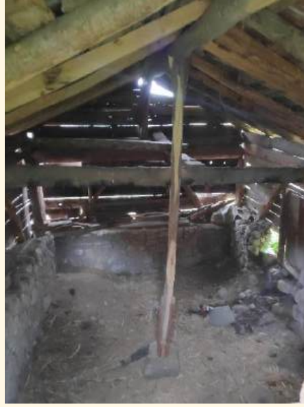
Şekil 2.29. Samanlık iç düzeni örneği (Çataklı mahallesi)
