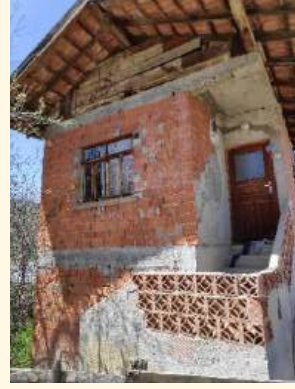
b) Yığma sistem modern malzeme (Yuvalar mahallesi)
