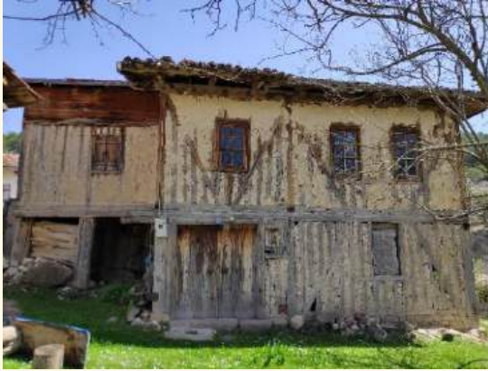
a) Karkas sistem geleneksel malzeme (Alizaim mahallesi)
