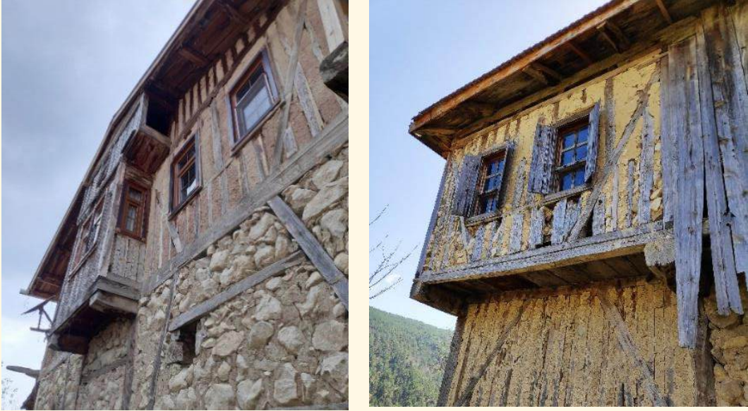
Şekil 4.36. Dudaş köyünde konsol kirişli çıkma örnekleri (Aliziam mahallesi)
