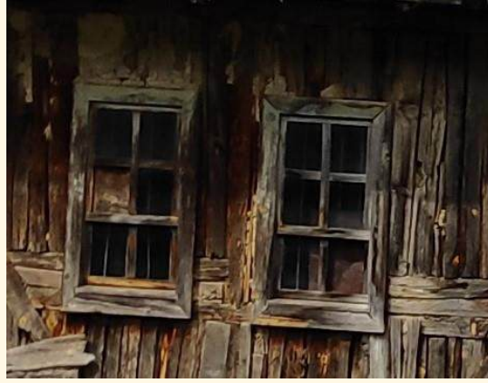
Şekil 4.54. Ahşap giyotin pencere örneği (Beri Güvez mahallesi)
