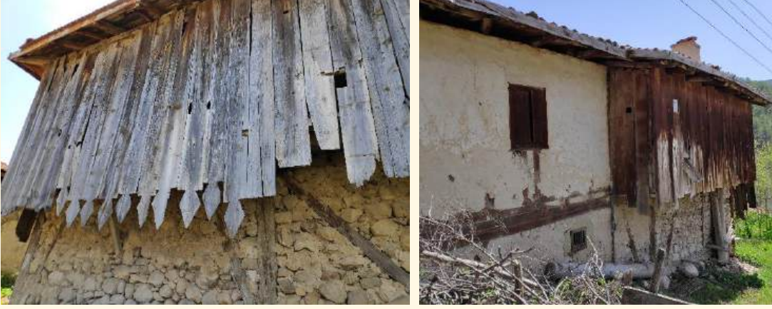
Şekil 4.40. Kaplama tahtalarıyla kapatılmış kapalı çıkma örnekleri
