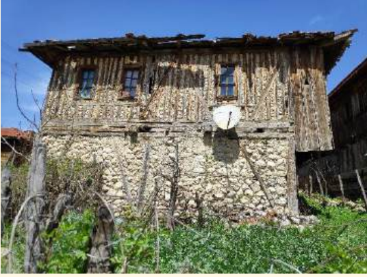
a) Özgün yapı örneği (Alizaim mahallesi)
