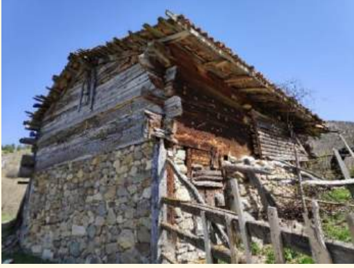
a) Yığma sistem geleneksel malzeme (Kızılelma mahallesi)
