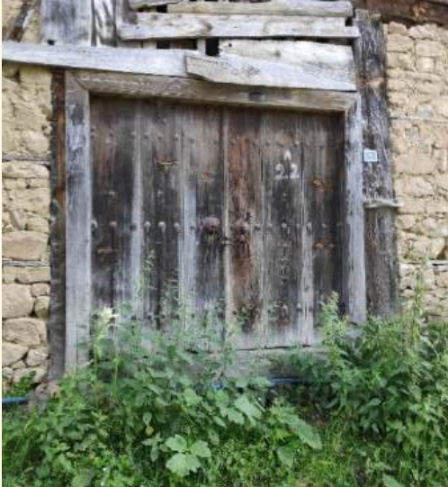
Şekil 4.49. Çift kanatlı ahşap kapı örneği (Dudan mahallesi Osman Gökler evi)
