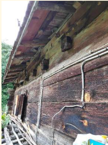
Şekil 4.33. Cephede tavan kirişleri (Çataklı mahallesi Ramazan Çataklı evi)
