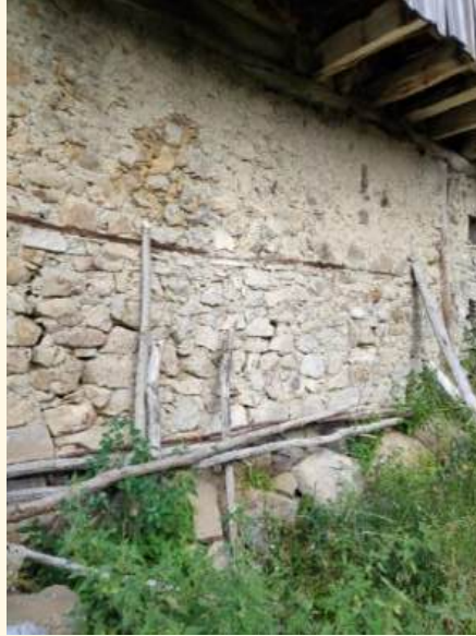
Şekil 4.10. Dağdibi mahallesi yığma taş duvarda ahşap hatıl kullanımı
