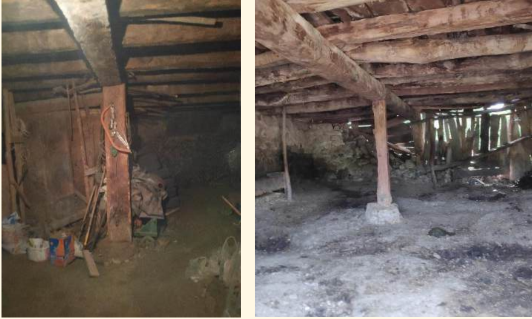
Şekil 4.9. Ahşap dikmelerin taş bloğa oturtulması
