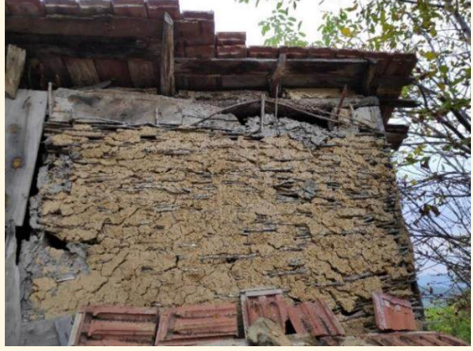
Şekil 4.21. Örgü dallar ile duvar oluşumu
