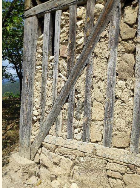
Şekil 4.22. Taş temelin üzerine oturtulmuş dikme örneği
