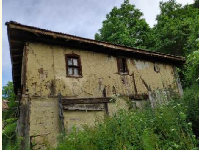
Şekil 4.12. Dudan mahallesi dolgu malzemesi olarak kerpiç kullanımı
