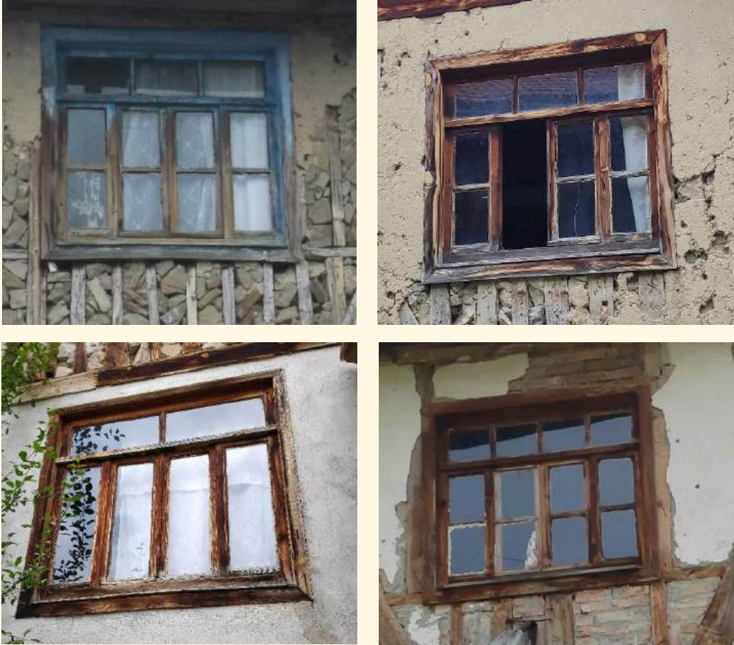
Şekil 4.53. Dört kanatlı ortadaki kanatları açılır pencere örnekleri
