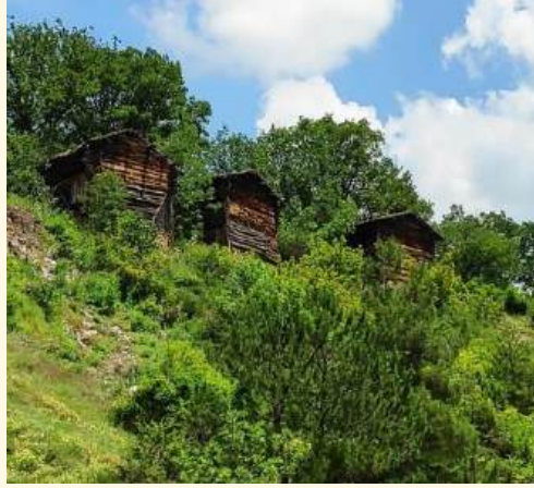
Şekil 2.27. Mıcık mahallesi samanlıklarının genel görünümü
