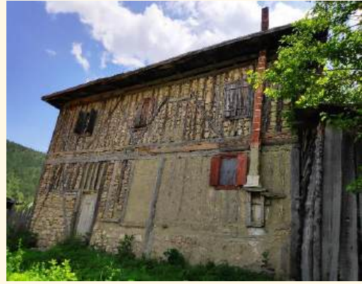
b) İyi durumda yapı örneği (Mıcık mahallesi)
