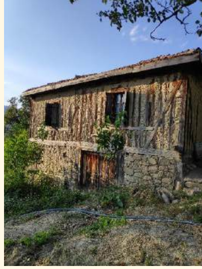
d) Orta durumda yapı örneği (Mıcık mahallesi)
