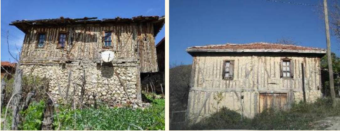
Şekil 4.19. Ahşap iskelet sistemli yapı örnekleri
