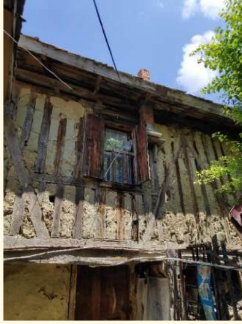
Şekil 4.5. Ahşap karkas arası kerpiçle doldurulmuş konut örneği (Alizaim mahallesi)
