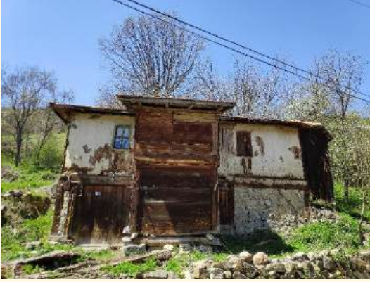
c) Karma sistem geleneksel malzeme (Çataklı mahallesi)
