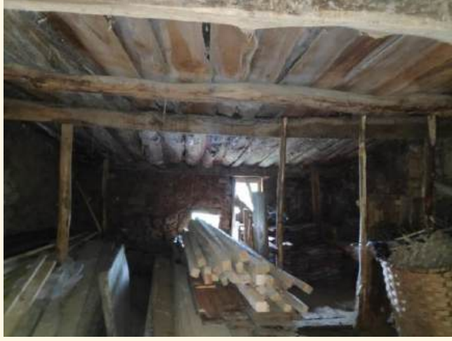
Şekil 4.34. Kirişlerin açıkta bırakıldığı tavan örneği
