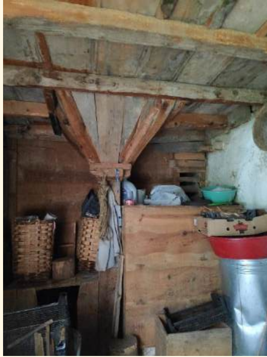
Şekil 4.59. Ocak kaidesinin farklı bir teknikle oluşturulması
