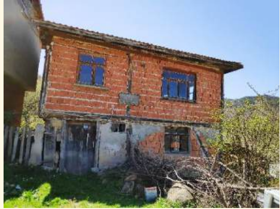
b) Karkas sistem modern malzeme (Yuvalar mahallesi)
