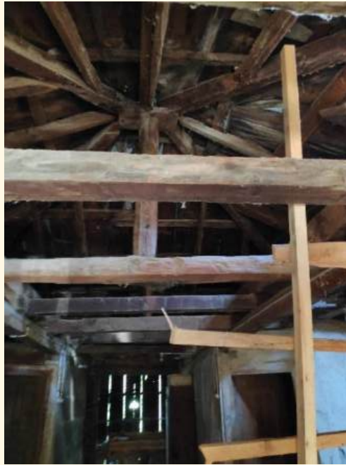
Şekil 4.35. Çardak ile çatı arasında döşeme bulunmayan tavan örneği (Yuvalar mahallesi Recep Temam evi)
