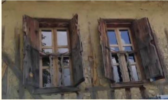
Şekil 4.55. Ahşap kapaklı ve parmaklıklı giyotin pencere örneği (Mıcık mahallesi)
