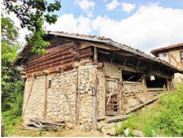
Şekil 2.30. Alizaim mahallesinde bulunan ahır örneği
