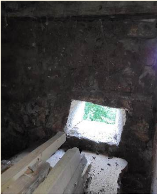
a) Temek penceresi yapı içerisinden
