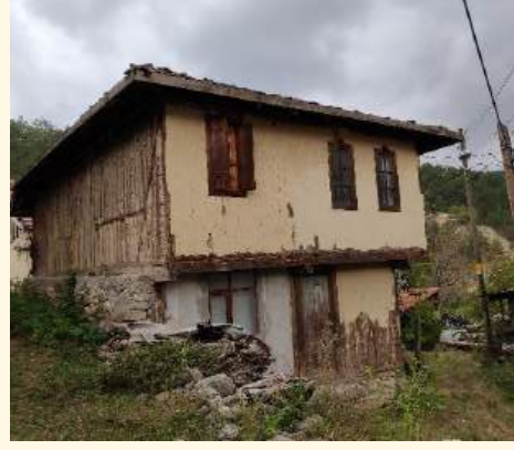
d) Az değişmiş yapı örneği (Alizaim mahallesi)
