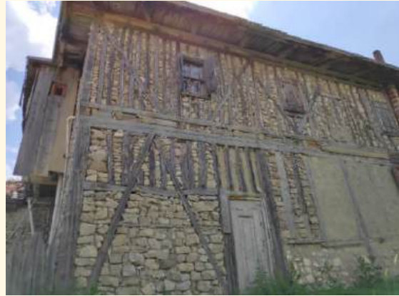
b) Alizaim mahallesinde taş malzeme kullanımı
