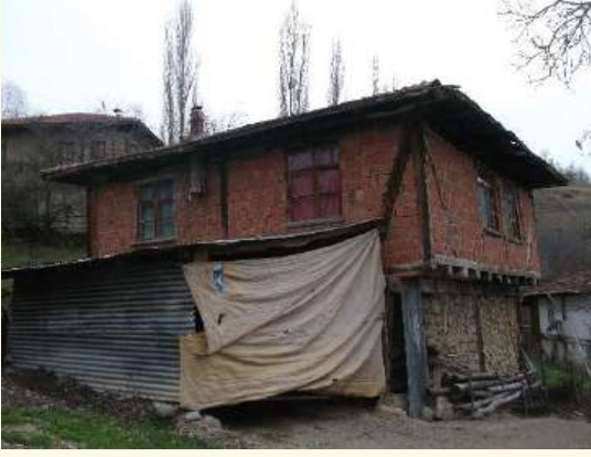
a) Yuvalar mahallesi malzeme değişikliği
