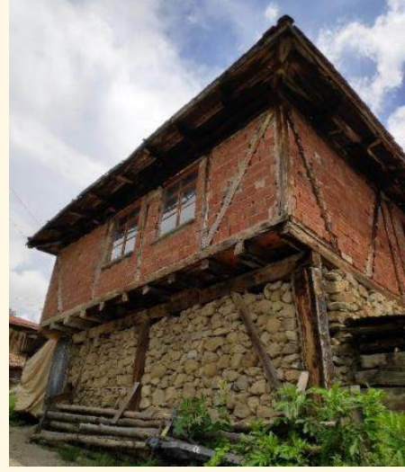
b) Yuvalar mahallesi taş duvar örneği
