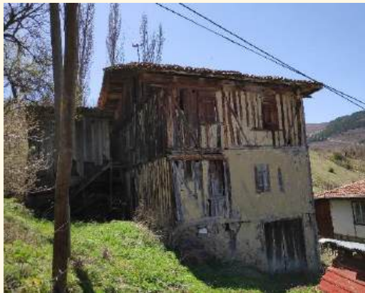
e) Üç katlı yapı örneği (Yuvalar mahallesi)
