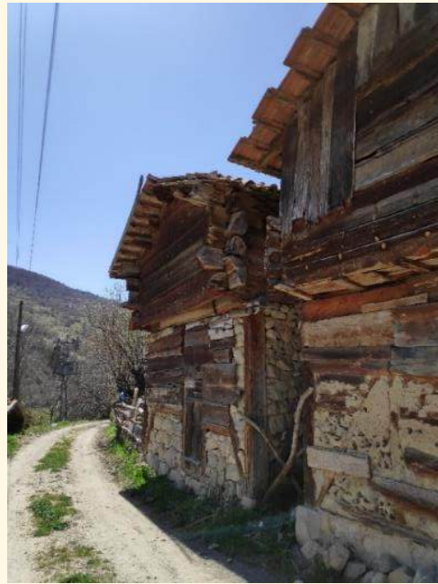
Şekil 2.28. Samanlıkta ahşap çantı örneği (Çatakli mahallesi)
