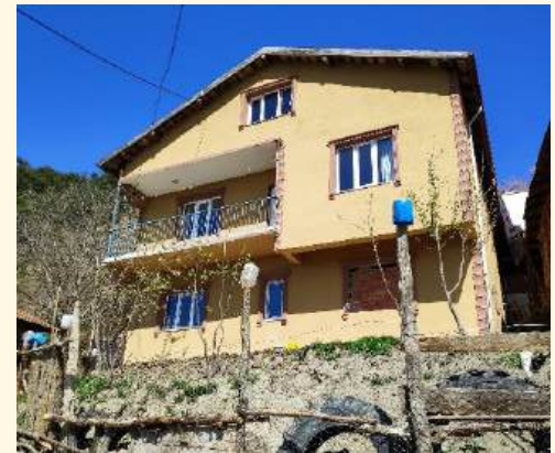
f) Üç katlı yapı örneği (Yukarı Kayalar mahallesi)
