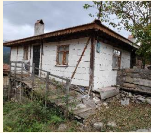
f) Çok değişmiş yapı örneği (Alizaim mahallesi)
