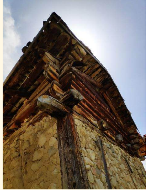
Şekil 4.17. Dudaş köyü samanlık yapılarında ahşap yığma duvar örnekleri
