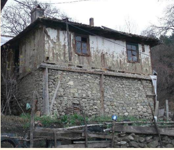
a) Yukarı kayalar mahallesi taş duvar örneği
