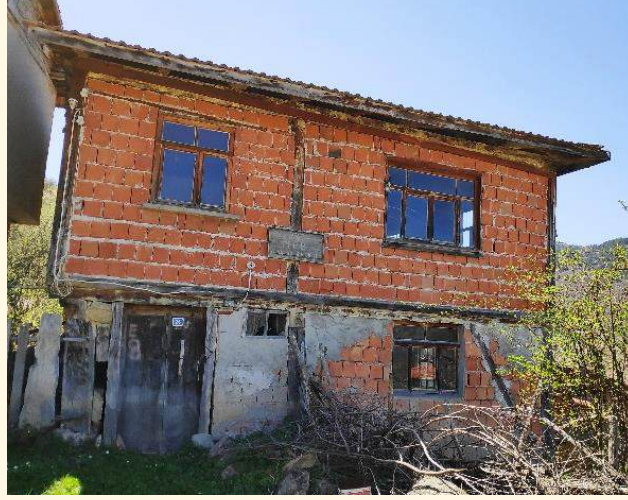
Şekil 2.11. Yuvalar mahallesinde bulunan ilkokul yapısı
