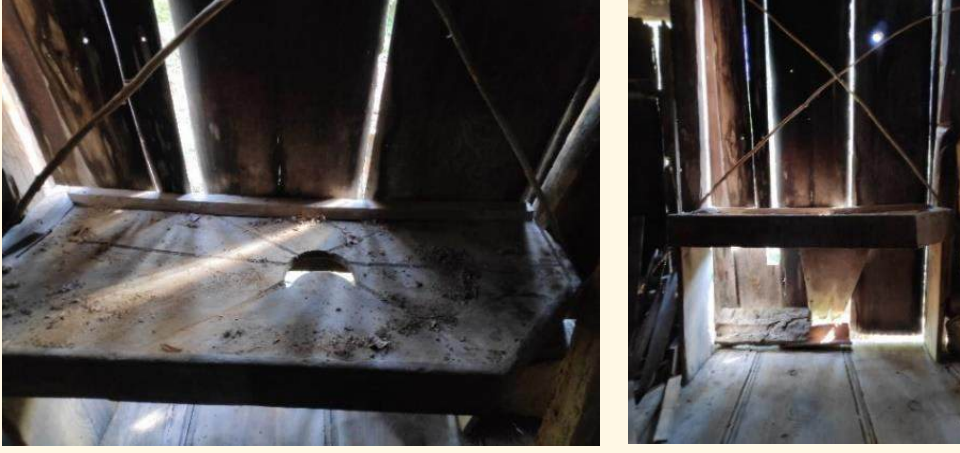
Şekil 2.24. Özgün lavabo örneği (Yuvalar mahallesi Ayşe Hanım evi)
