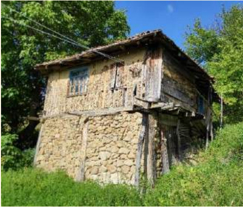
a) Dağdibi mahallesinde taş malzeme kullanımı
