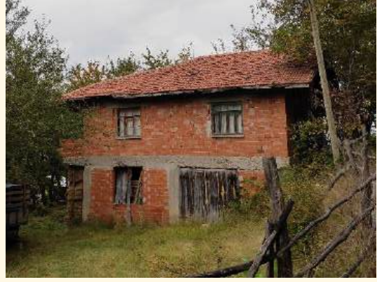
h) Yeni yapı örneği (Yuvalar mahallesi)
