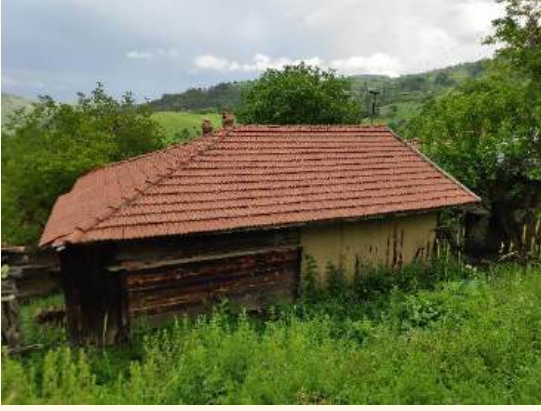
c) Üç omuz çatı örneği (Çataklı mahallesi)
